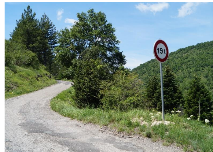
Limitation de tonnage sur une voie communale
