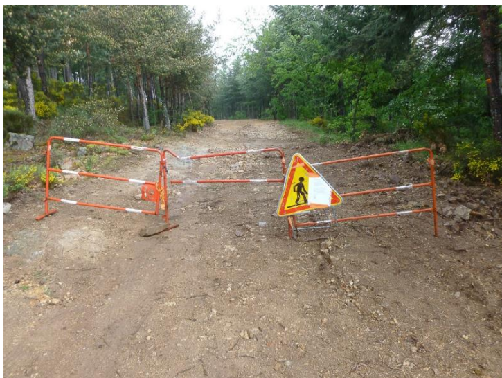
Remise en état d'un chemin rural
